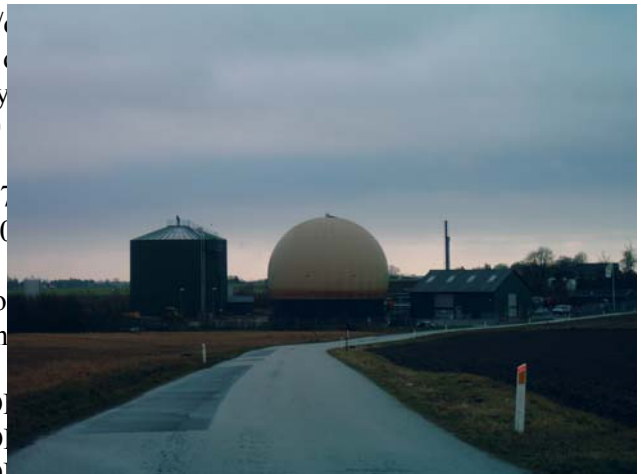
Fig. 3: Biogas plant in Hashøj
